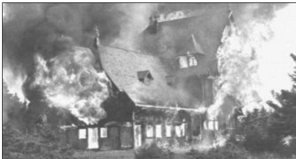
Figure 4.13 Le « Château Menier » incendié en 1954. Source © BAnQ, dans Brisson (2007)
