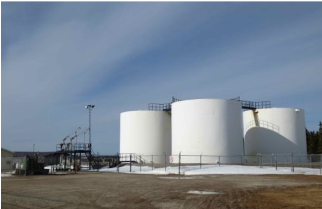
Figure 5. 12 Le dépôt pétrolier à Port-Menier géré par la CCIA
